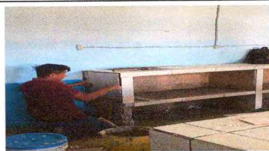
FOTO 8: REPARACION DE AZULEJO EN MUEBLES 25*20 CM
