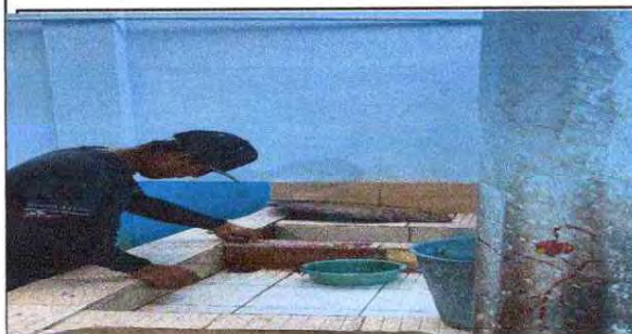
FOTO 3: SUSTITUCION DE TUBERIA LINEA PRINCIPAL AGUAS NEGRAS EN BAÑOS
