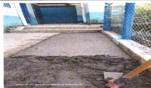
FOTO 16: SUSTITUCION DE PISO DE TIERRA POR PISO DE TORTA DE CONCRETO
