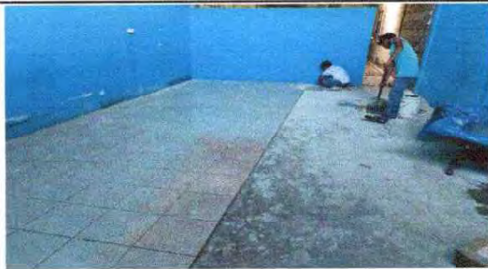
FOTO 15: SUSTITUCION DE PISO DE TORTA DE CONCRETO POR PISO CERAMICO 30X30 EN MODULO AULA 10
