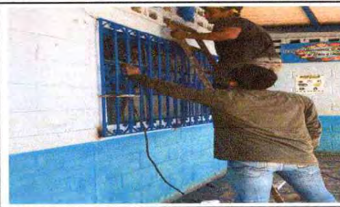
FOTO 12: FABRICACION A BALCONES DE METAL AULAS 1,2,3,4
