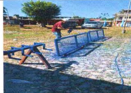
FOTO 18: MANTENIMIENTO A PORTONES DE METAL EN PATIO
