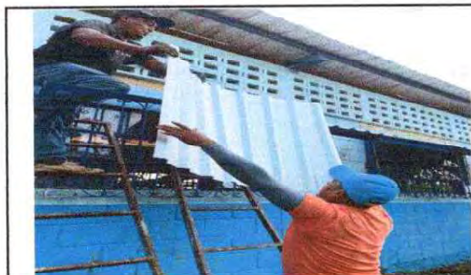
FOTO 9: SUSTITUCION DE LAMINA POR LAMINA TROQUELADA CALIBRE 26 Y SUSTITUCION DE SOPORTE DE MADERA POR METAL EN AULAS
