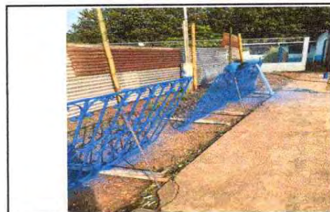
FOTO 11: FABRICACION E INSTALACION DE BALCONES DE HIERRO EN VENTANA
