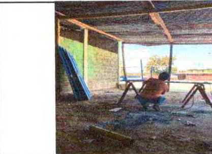
FOTO 10: MANTENIMIENTO A ESTRUCTURA (LUJADO, CAMBIO DE TUBO, CEPILLADO, SUJECIONES, APLICACIÓN DE PINTURA) PUERTAS DE AULAS
