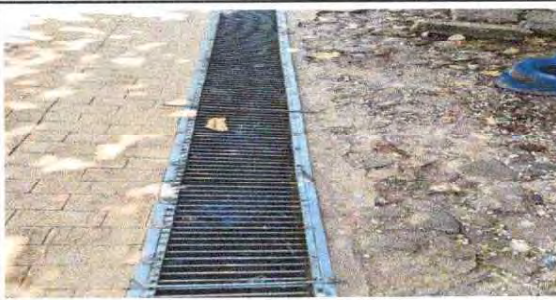
FOTO 17: REPARACION DE CUNETETA DE CONCRETO REJILLA EN PATIO
